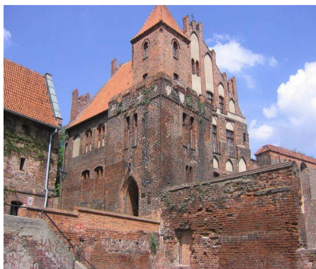
Het Podmurna gebouw in Toruń:
